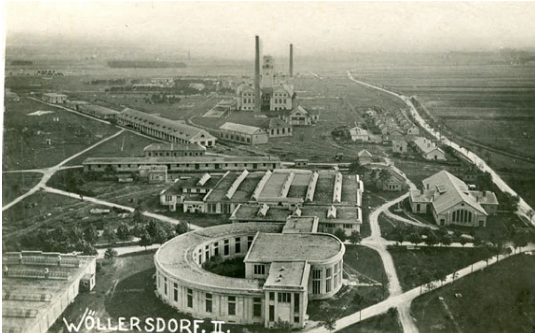
Luftaufnahme der Wöllersdorfer Werke; Postkarte aus 1936. Bei dem markanten Gebäude im Vordergrund handelt es sich um das einzige heute noch erhaltene Bauwerk.
