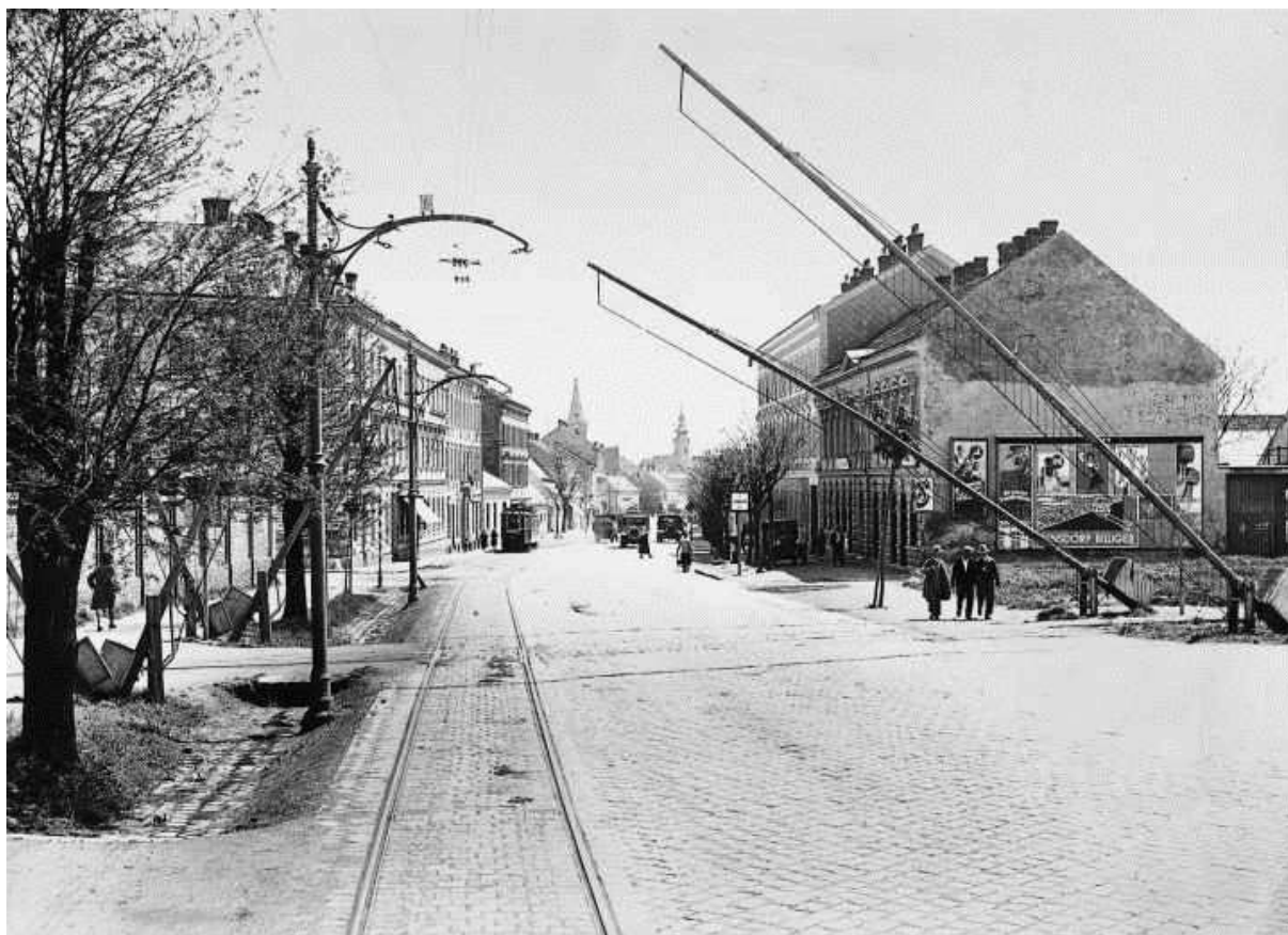
Die Bahnschranke der Brauhausbahn, bei der Spirik und seine Männer die Barrikade errichteten. Er wurde gegen 20 Uhr beim linken Schrankengewicht tödlich getroffen.
